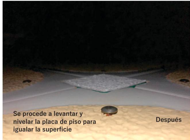
Se procede a levantar y nivelar la placa de piso para igualar la superficie
